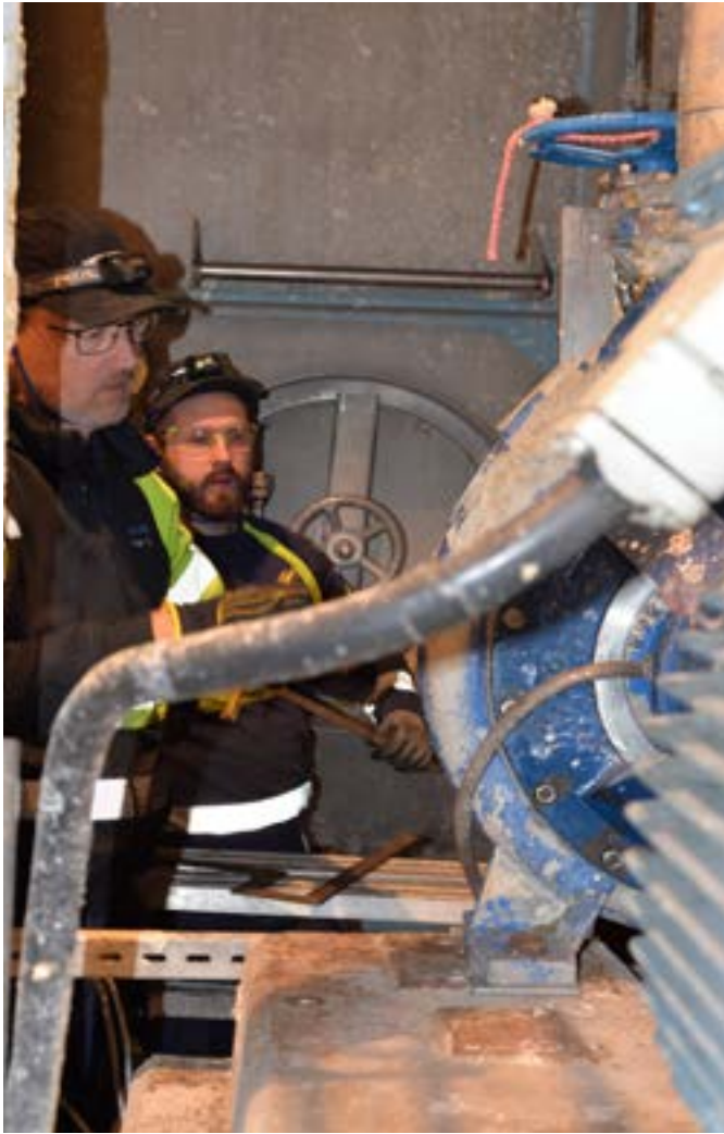
Roger Carlberg och Staffan Nyberg tar mått på en rördel på PM11 som skall nyttillverkas
