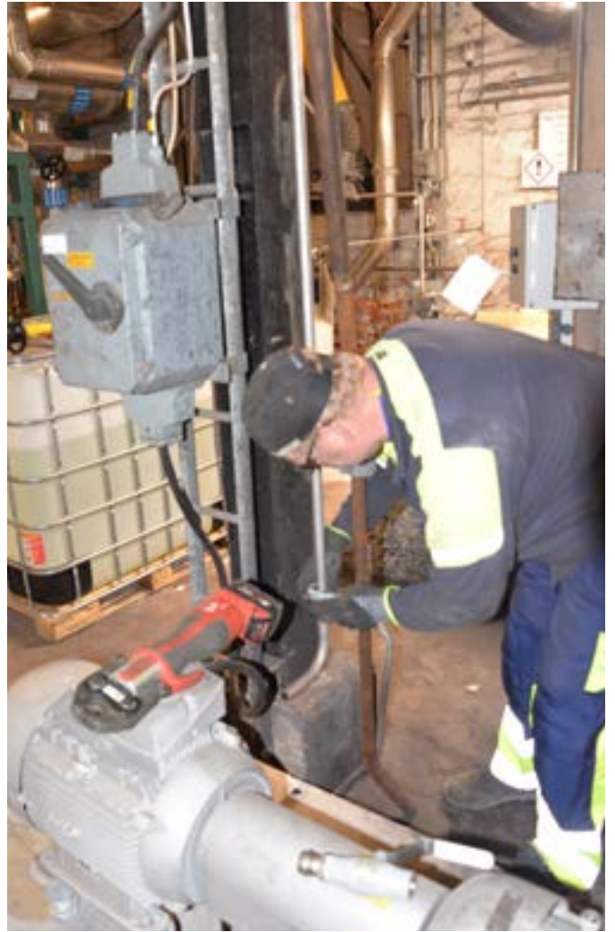
Micael Strandbergh monterar en rutventil på en kylvattenledning
