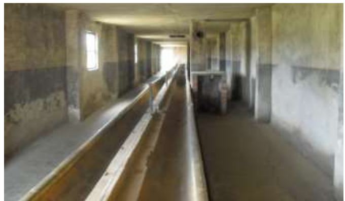
Bad och tvätthuset - Auschwitz
