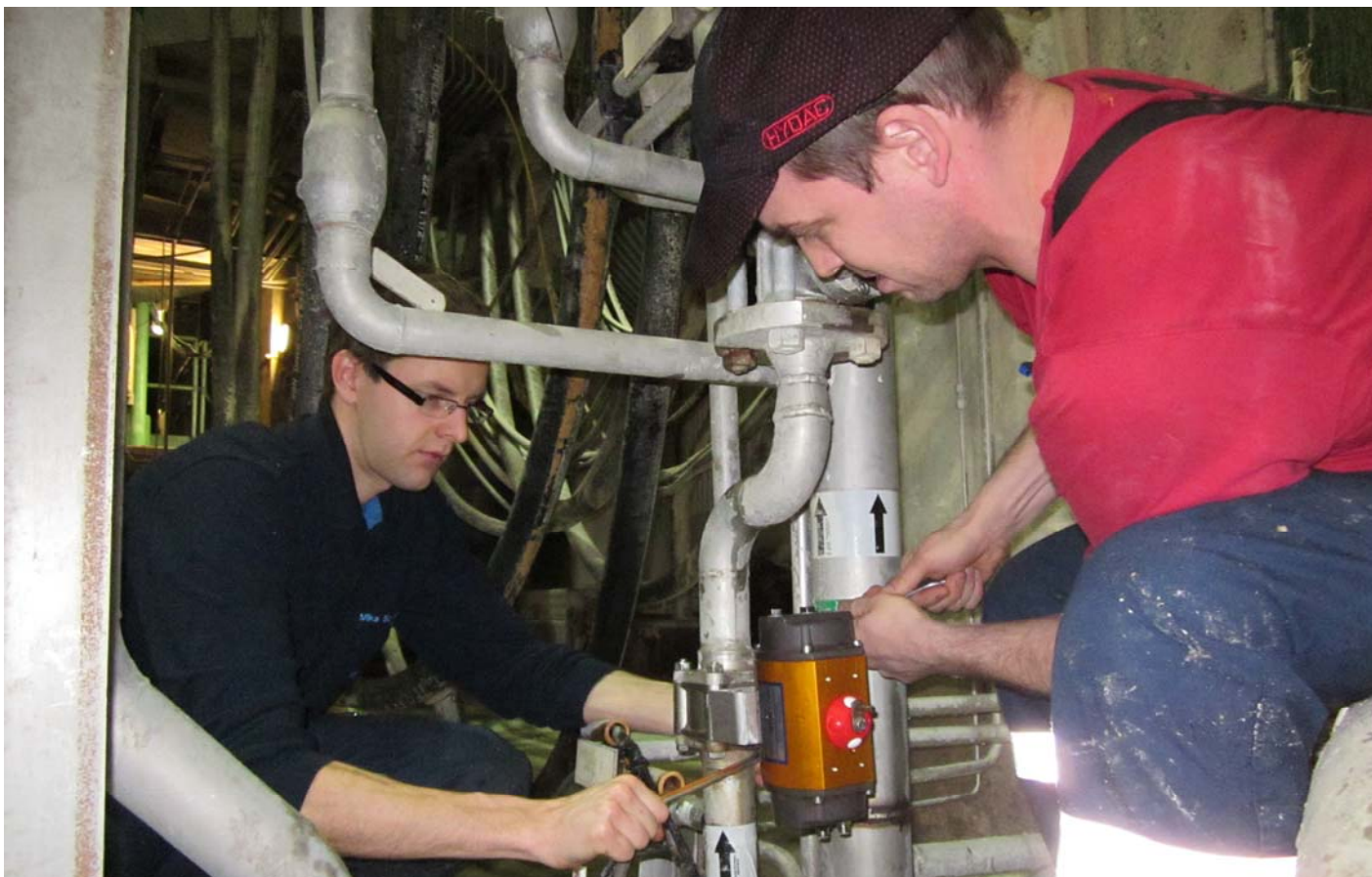
Mika Sällinen och Patrik Lundberg byter on/off-ventil till högtryckssprits på PM 12
