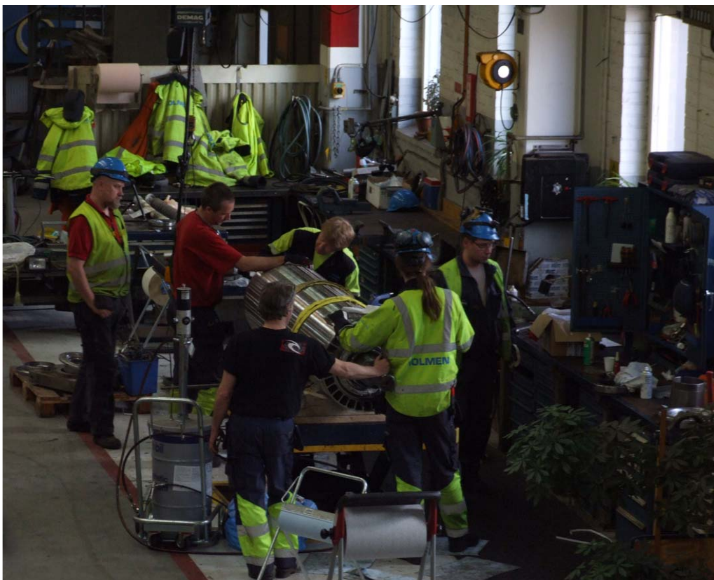
Reparation av en bandpressvals
