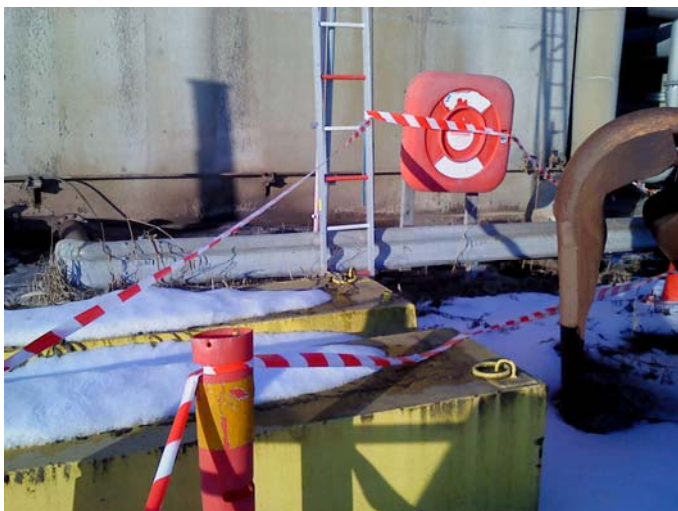
Bristfällig avspärning norra kajen
