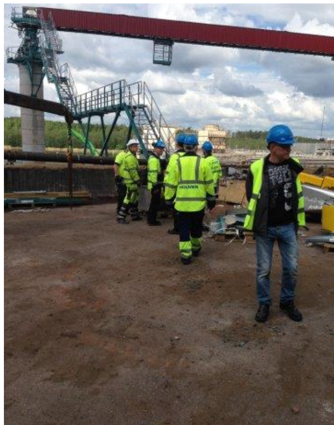
Inspektion av nya barkhanteringen
