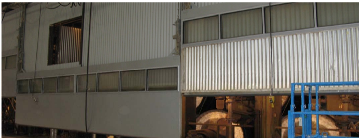
Nya plåtväggar byttes också på PM12 snyggt blev det
