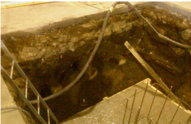
Järnvägssyllarna syns en bit ner i marken
