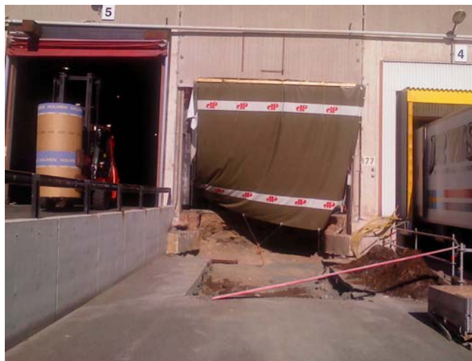
Ramp 5 byggs i sept 2013
