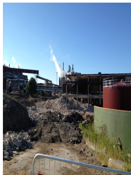
Rivning av VL4-5 pågår
