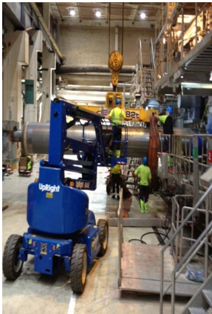
Här är valsen nästan ute från maskin och man stroppar om för att kunna lyfta med traversen
