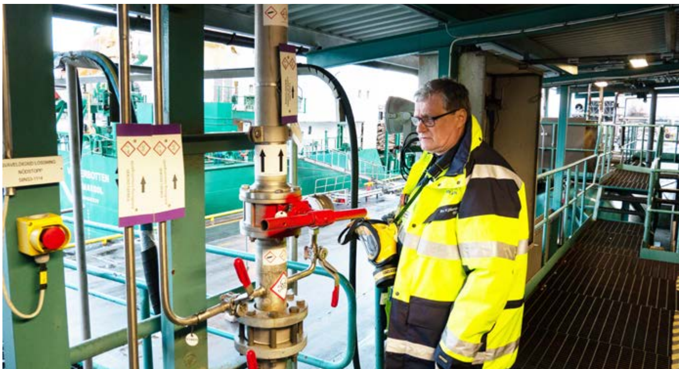
Arkivbild: avgasning av SO 2 ledningar efter avslutad lossning
