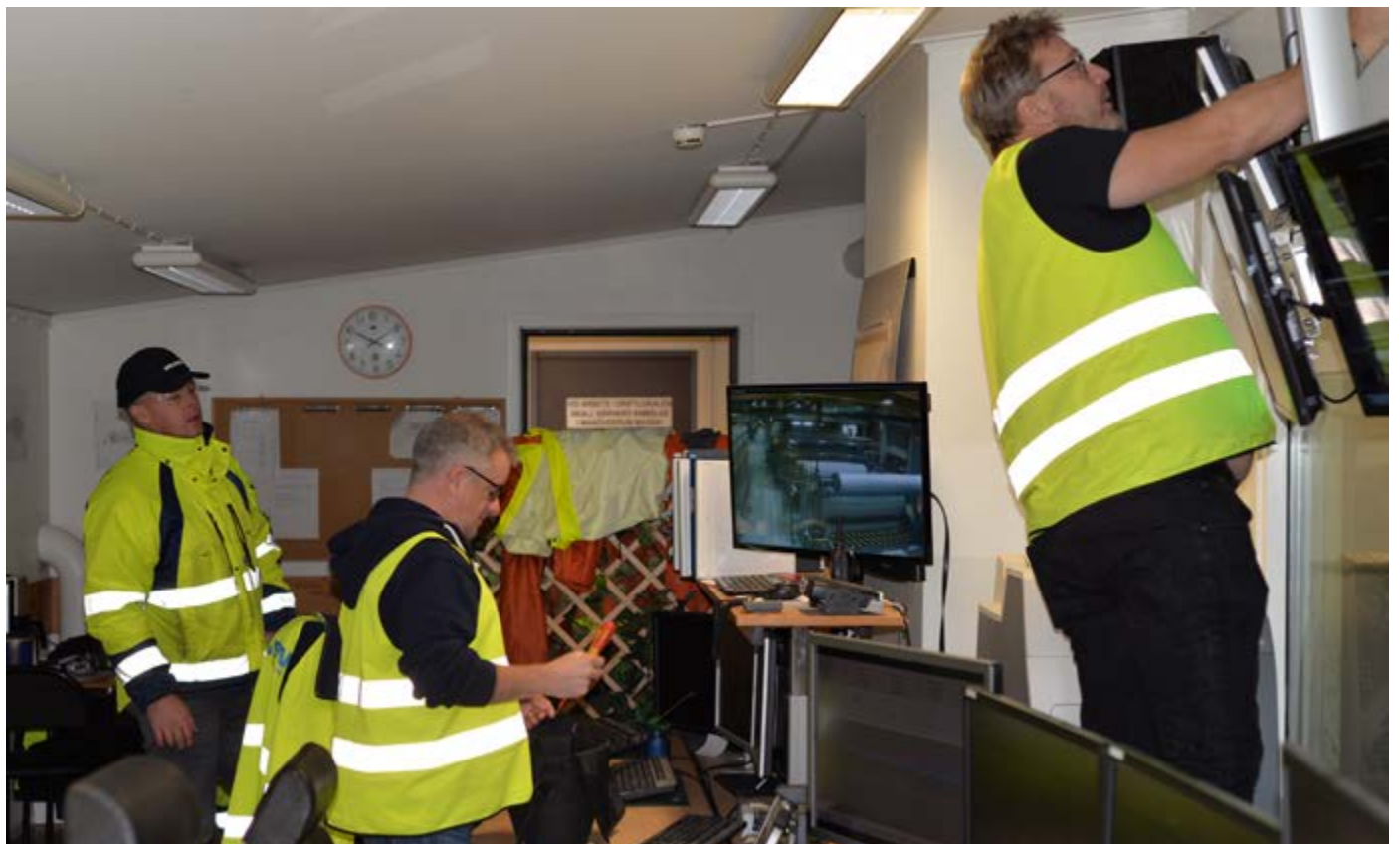
Mika, Patrik och Mats rensar ut gammal utgång IT utrustning i blekeriets manöverrum
