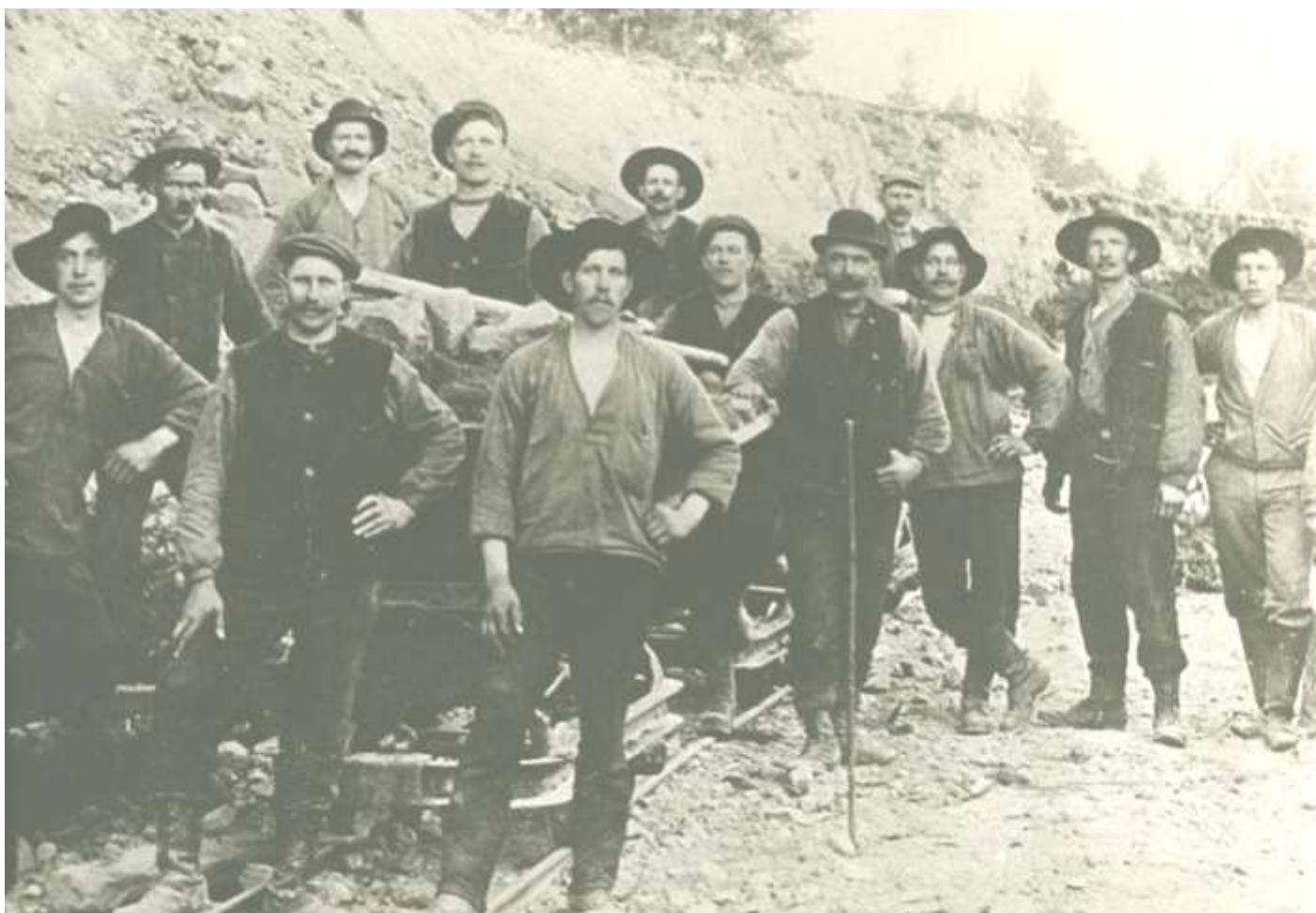
Rallare som Wilhelm arbetade tillsammans med vid bygget av Hallsta Pappersbruket 1913 - 1915. Eventuellt är det Wilhelm som står längst fram i mitten med uppknäppt skjorta.
