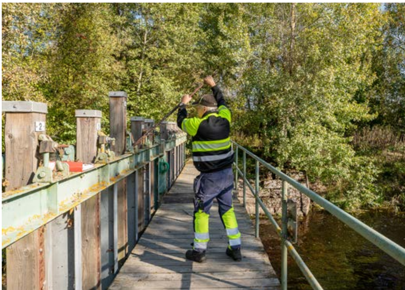
Urban öppnar en dammlucka för att materialet som samlats och hindrar vattenflödet ska spolas iväg. Det har hänt att det legat nedfallna träd och hindrat vattenflödet. Därför är det så viktigt att dessa kontrollrundor görs flera gånger per vecka.
