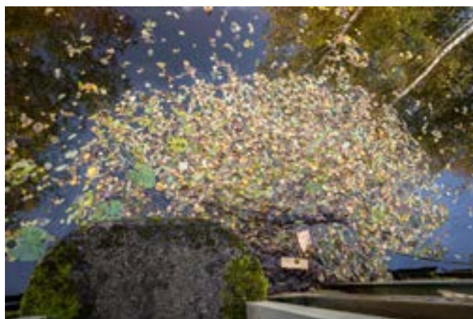
Här har vedklabbar, kvistar och löv samlats vid dammluckorna och hindrar vattnet från att flöda fritt.
