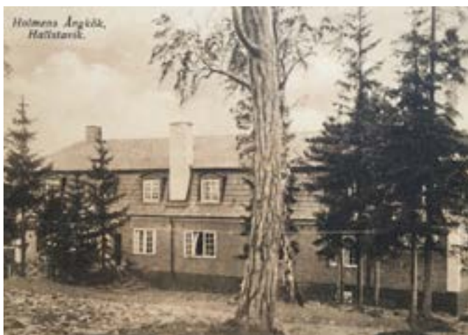
Bild 4 - Ångköket stod klart 1916 och bilden visar den södra fasaden
