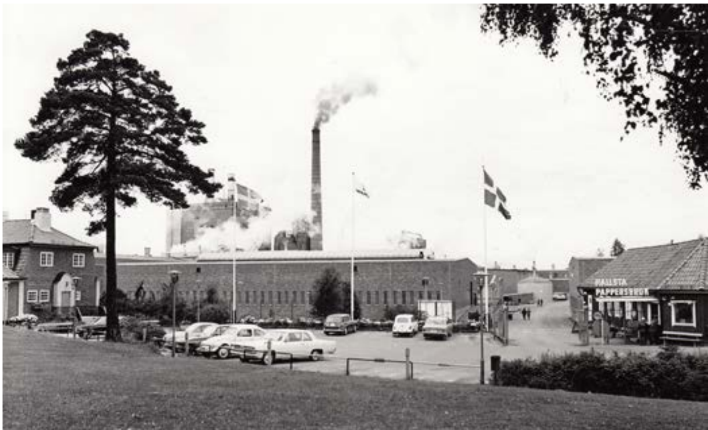
Hallsta pappersbruks huvudentré någon gång före 1984. Den höga skorstenen revs våren 1984.
