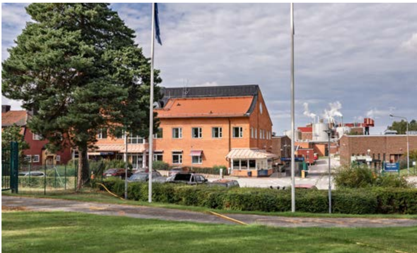
Nuvarande huvudentrébyggnad, Valhall, byggdes 1987 och innehåller reception, vakt, företagshälsövård, konferensrum och matsal med restaurangkök. För närvarande är det ingen som driver restaurangen.
