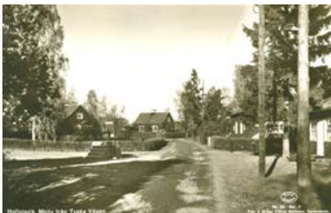
I korsningen Tyska vägen - Mäster Smeds väg står en vattenpump. I höger bildkant syns tvättstugan.
